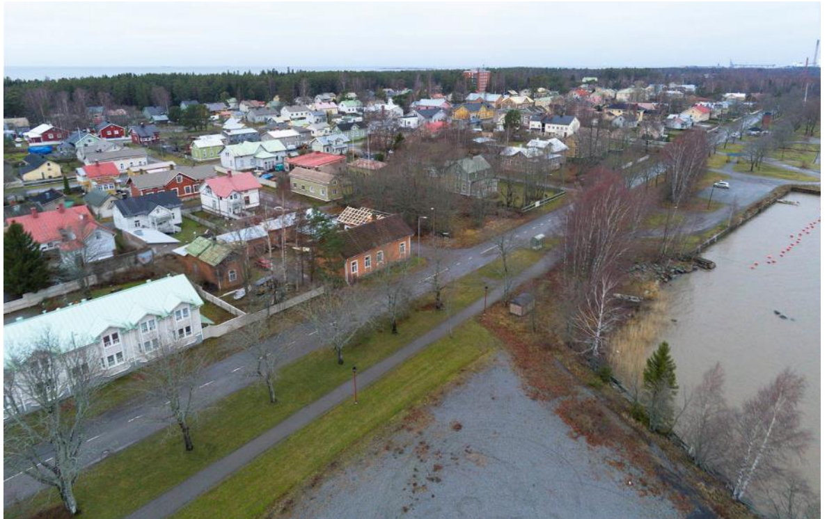
Kuva 11-10. Valokuva Reposaaren Kaupparannan suunnasta asuinalueen yli kohti Tahkoluodon nykyisiä tuulivoimaloita.
